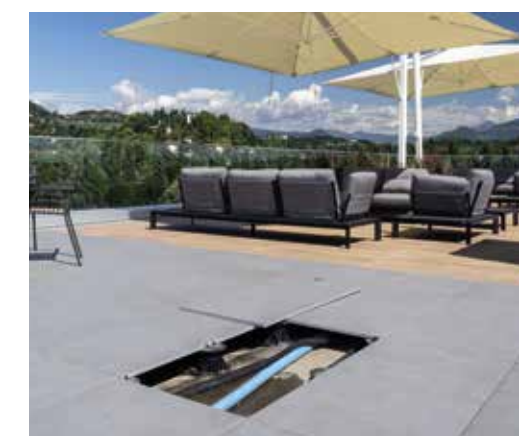
SUPPORTO REGOLABILE . ADJUSTABLE SUPPORT . VERSTELLBARE STÜTZE . VÉRIN RÉGLABLE
